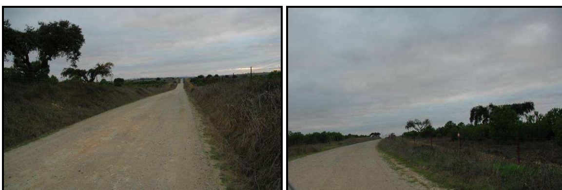
Figura 3.59 e 3.60 – Registo fotográfico dos PK 8+800 e 9+000 do Caminho Municipal.
