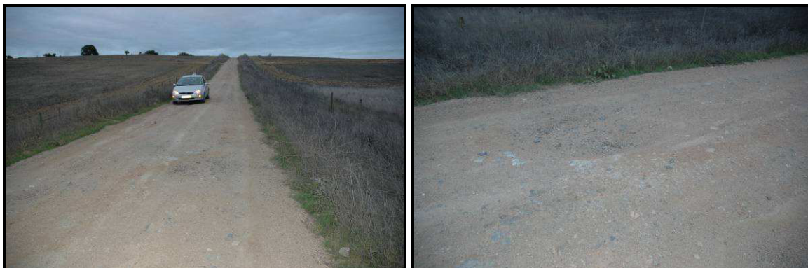
Figura 3.49 e 3.50 – Sensivelmente ao PK 7+950, numa zona baixa da via é perceptível a sua maior degradação (depressões), eventualmente por representar um ponto de drenagem superficial de escorrências pluviais.
