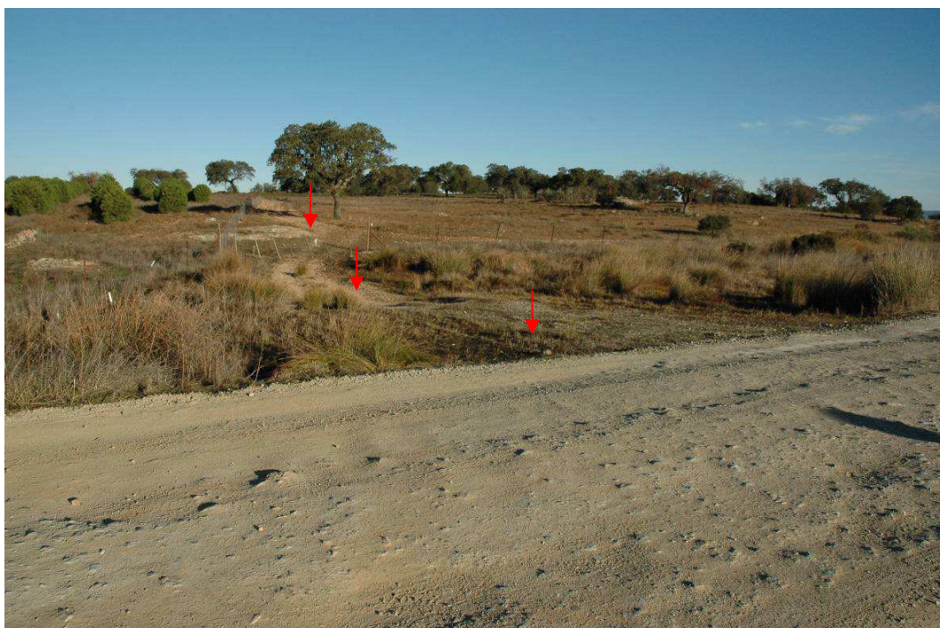
38 - Corredor final correspondente ao Pk 9+200, com futuro acesso á barragem da Amendoeira (Estrada das Apolinárias)
