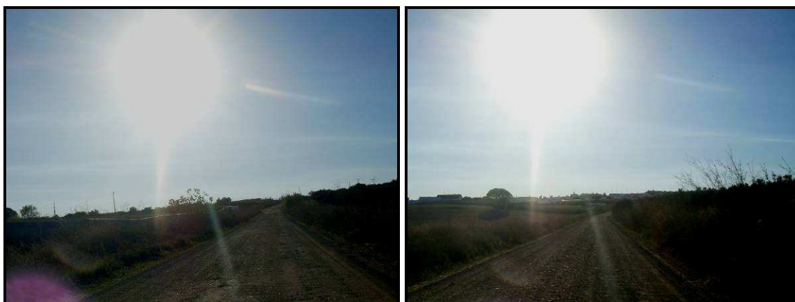
Figura 3.5 e 3.6 – Registo fotográfico dos PK 0+800 e 1+000 do Caminho Municipal.
