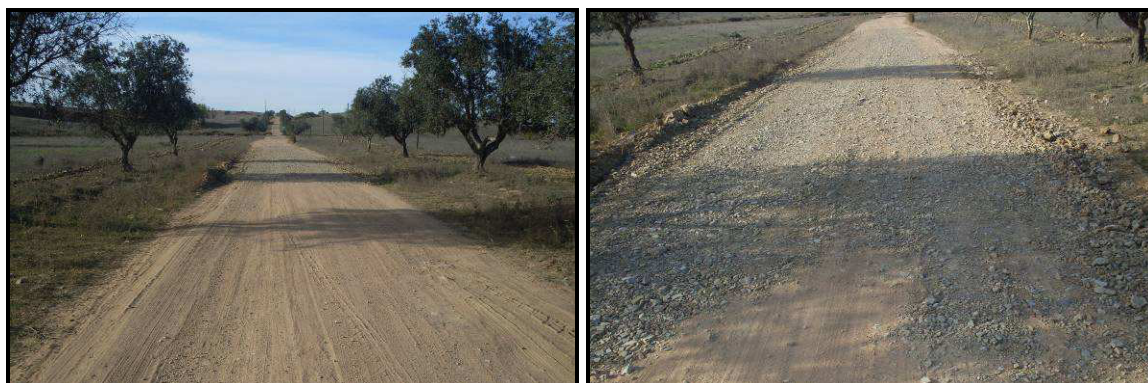
Figura 3.70 e 3.71 – Registo fotográfico dos PK 0+200 ao 0+250 do Acesso Privado, onde é visível a colocação de brita para consolidação do mesmo.
