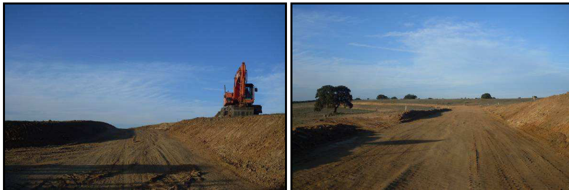
Figura 3.97 e 3.98 – Registo fotográfico dos PK 3+000 (após passarmos pelas plataformas de estaleiro) e 3+200 (entrando já no acesso definitivo à barragem da Magra).
