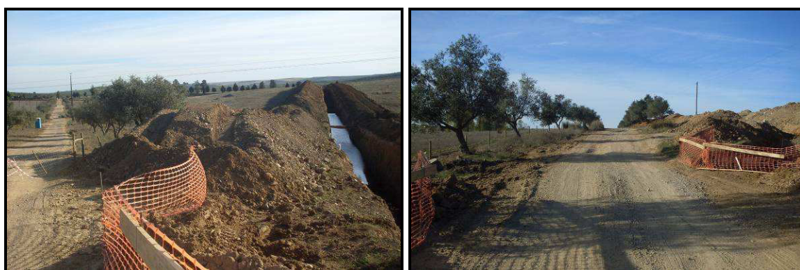
Figura 3.74 e 3.75 – Sensivelmente ao PK 0+600, verifica-se a 2.ª interseção da Rede Secundária do CHSPB, passando o acesso a ter, paralelamente à sua progressão (pela direita no sentido IP8 – Monte da Magra), vala aberta e respetivo cordão de terras depositado.
