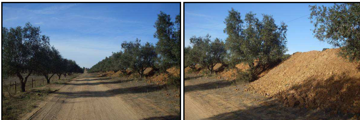
Figura 3.76 e 3.77 – Registo fotográfico do PK 0+800 do Acesso Privado, com a deposição das terras da Rede Secundária.
