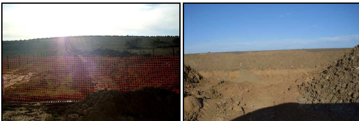
Figura 3.80 e 3.81 – Sensivelmente ao PK 1+050, verifica-se a 3.ª interseção da Rede Secundária do CHSPB.
