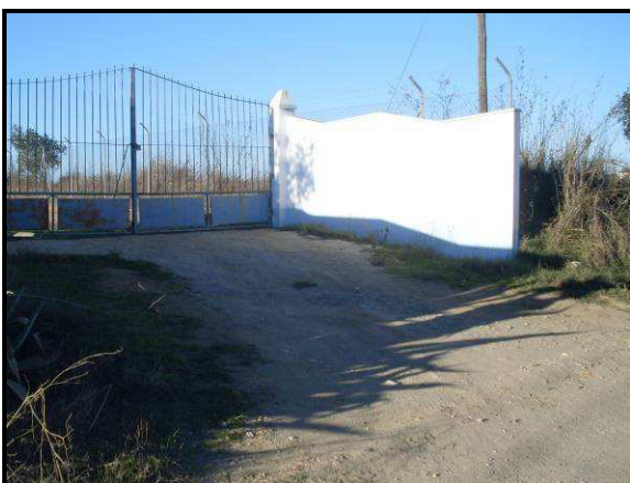
Figura 3.23 e 3.24 – Sensivelmente ao PK 3+700, junto da berma direita (sentido obra – IP8) verificam-se algumas irregularidades / depressões na faixa de circulação e correspondente degradação, frente à serventia de uma propriedade privada.
