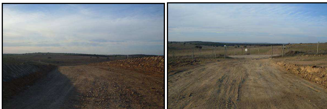
Figura 3.99 e 3.100 – Registo fotográfico dos PK 3+400 (acesso definitivo à barragem da Magra) e 3+500 (intersecção com o Caminho Municipal / acesso principal referido anteriormente).
