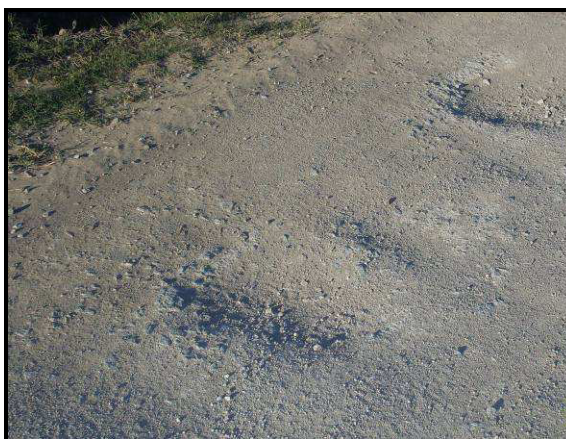
Figura 3.23 e 3.24 – Sensivelmente ao PK 3+700, junto da berma direita (sentido obra – IP8) verificam-se algumas irregularidades / depressões na faixa de circulação e correspondente degradação, frente à serventia de uma propriedade privada.
