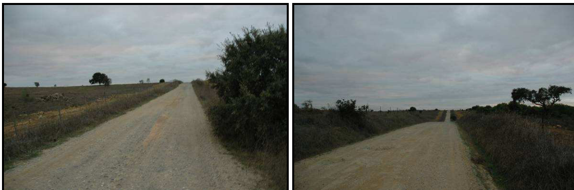
Figura 3.55 e 3.56 – Registo fotográfico dos PK 8+400 e 8+600 do Caminho Municipal.
