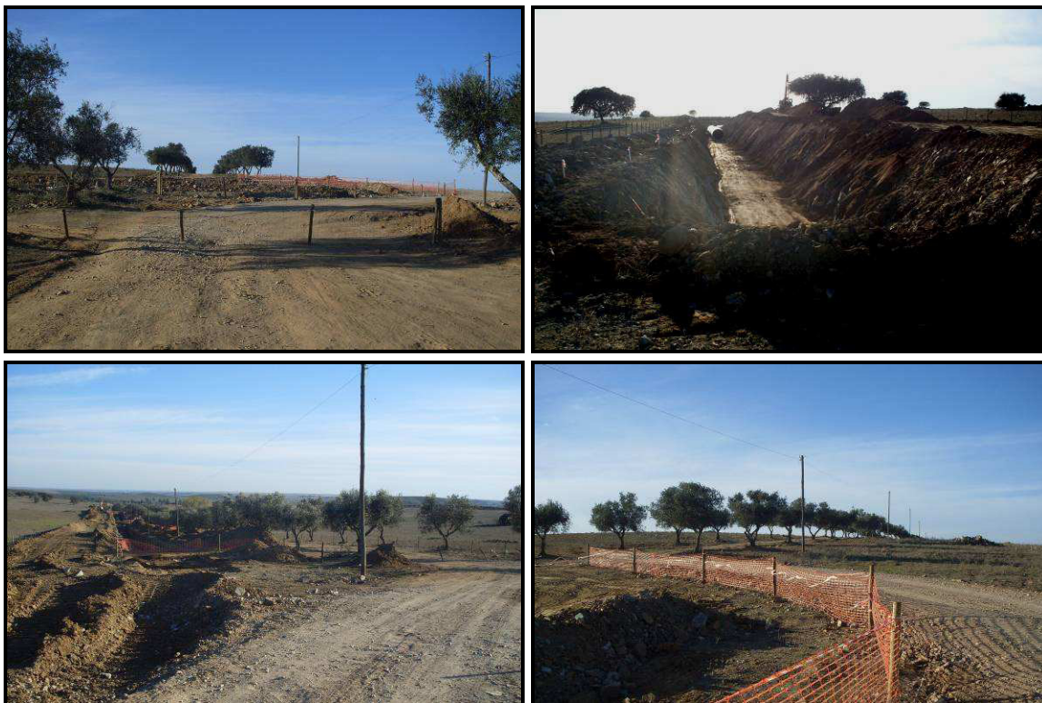
Figura 3.86, 3.87, 3.88 e 3.89 – Registo fotográfico do PK 1+600 ao 1+650, onde se verifica a interseção final da Rede Secundária do CHSPB, sendo o acesso restabelecido por um curto desvio.
