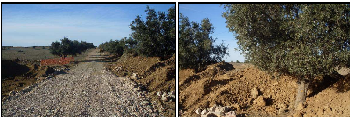
Figura 3.78 e 3.79 – Registo fotográfico do PK 1+000 do Acesso Privado, com a deposição das terras da Rede Secundária.
