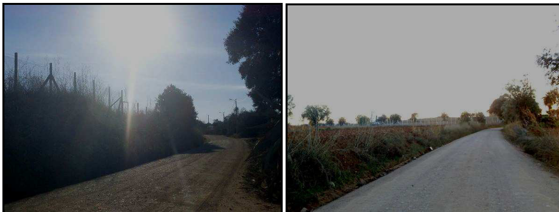
Figura 3.13 e 3.14 – Registo fotográfico dos PK 2+400 e 2+600 do Caminho Municipal.
