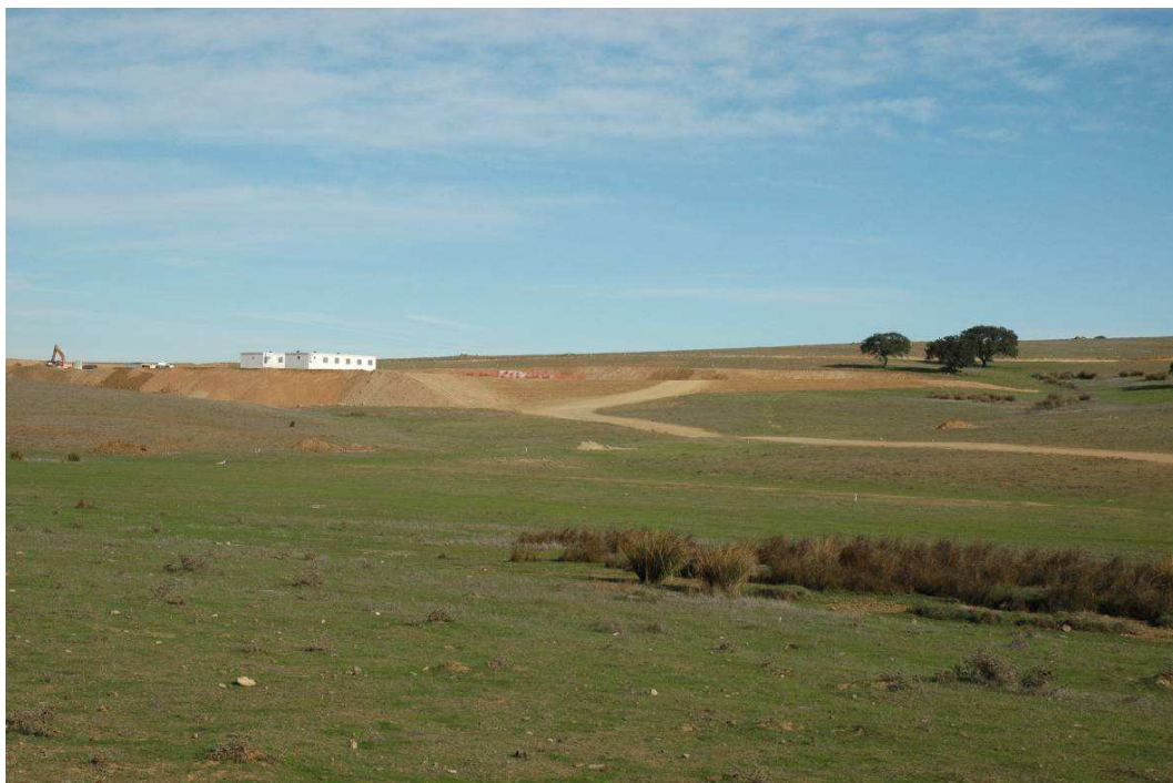
11 - Corredor correspondente ao Pk 3+000, já junto ao estaleiro de obra (Caminho Privado ao Monte da Magra)
